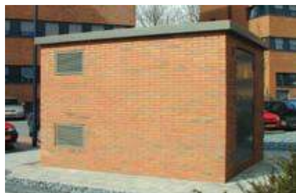
Trafo's in metselwerk uitvoeren
