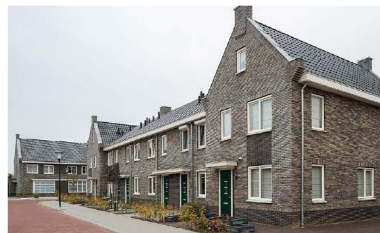
Begeleiding in daklijst en plint
