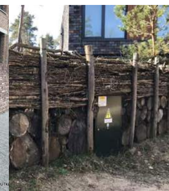
Nutskasten in erfafscheiding
