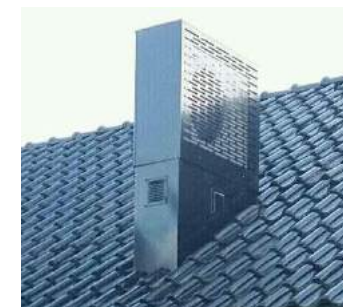
Warmtewisselaar ontworpen als schoorsteen
