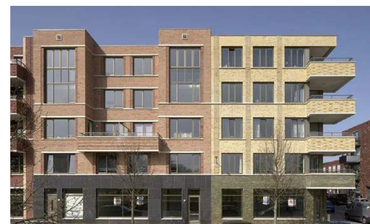
Verspringen in de massa van de appartementen
