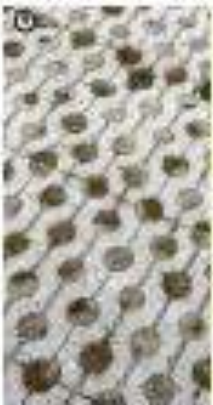
weegpaasende laag (breukende laag) opvullen met zand
