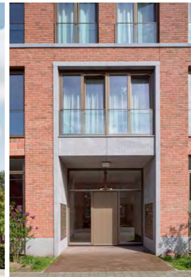
De hoogte van de entree van de appartementengebouwen past bij de schaal van het bouwvolume.
