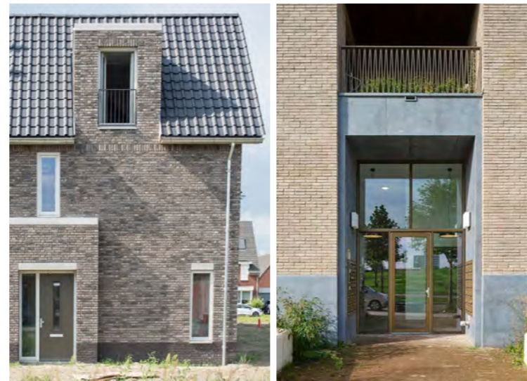
Kopgevels krijgen meer de uitstraling van een voorgevel door om de hoek door te ontwerpen.
