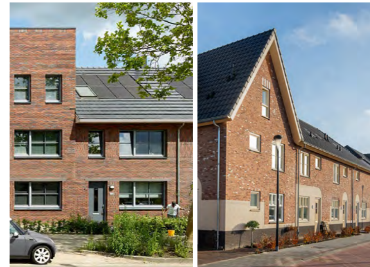
Lange lijnen doorbreken door dwarskappen of volledige bouwlaag. (foto's bewerkt door wUrck)
