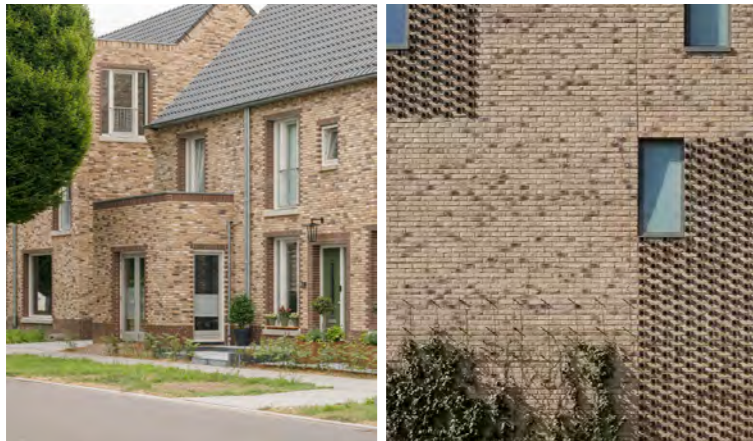
Bij toepassing van meerdere kleuren metselwerk wordt niet gezocht naar sterke contrasten maar naar subtiele verschillen.
