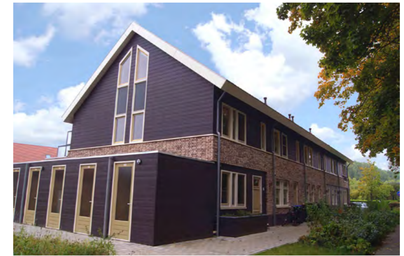
Bergingen geïntegreerd op de kop van rijtjes woningen. In kleur- en materiaalgebruik sluiten de bergingen aan op de architectuur van de woningen.
